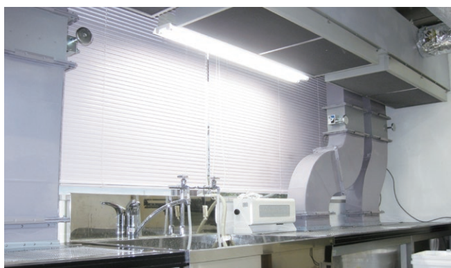
プッシュプル型換気装置の例 (病理検査室ホルムアルデヒド対策)
