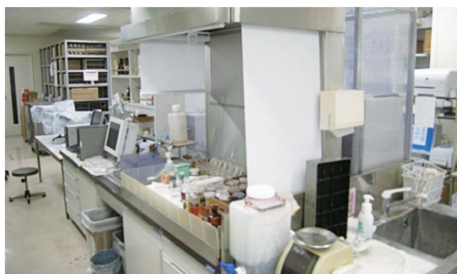
プッシュプル型換気装置の例 (病理検査室キシレン等有機溶剤対策)
