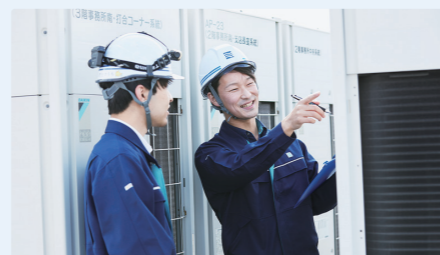
現場での施工管理では、安全を意識。
