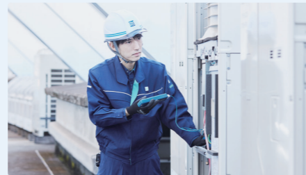
エアコン室外機の温度測定、運転状態の確認。
