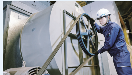
ファンのベルトに摩耗・亀裂がないか確認。
