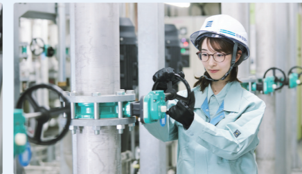
機械室で日常の巡視点検。
